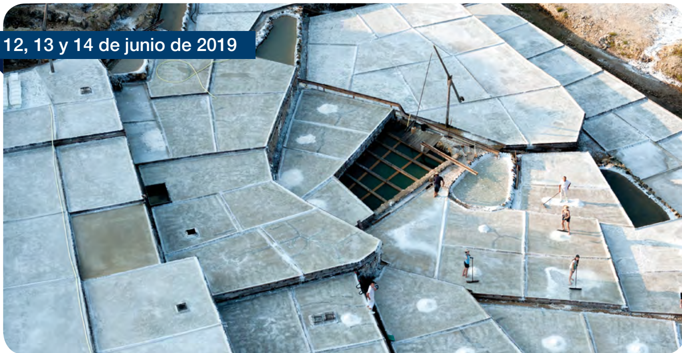
Fotografía superior: El Valle Salado de Añana tras su recuperación por Landa-Ochandiano Architects. © Fotografía: Landa-Ochandiano Architects.
