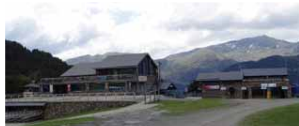
Conjunt d'edificis de serveis sense ús a l'estiu. Soldeu - el Tarter.
