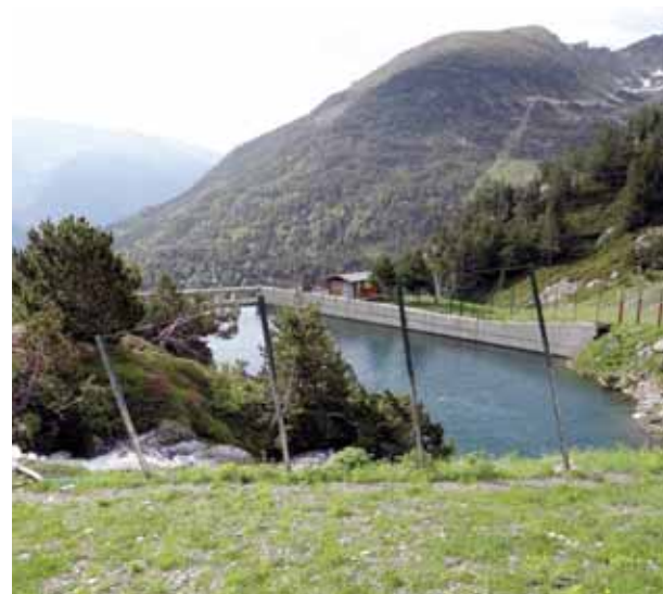
Bassa d'acumulació d'aigua amb una presa de formigó, Arcalís.
