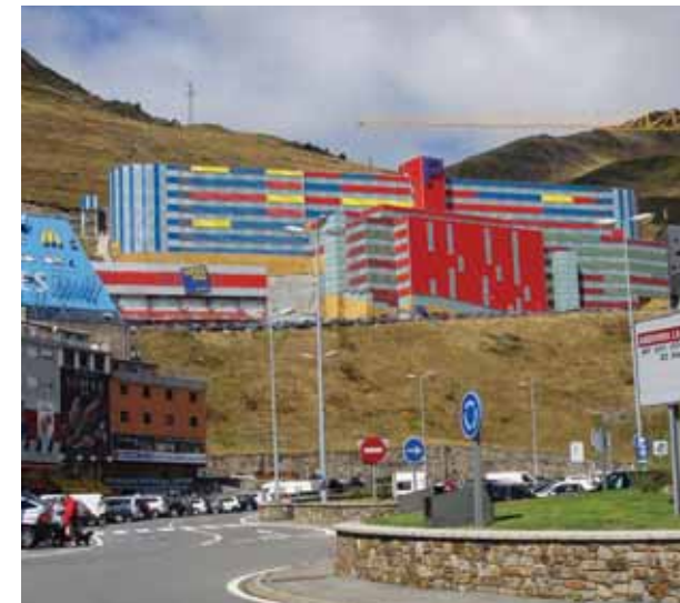
Gran edifici d'aparcament i comercial al Pas de la Casa.
