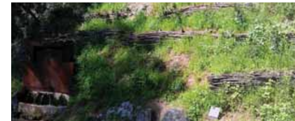
Estabilització amb feixines de branques. www.naturalea.eu
