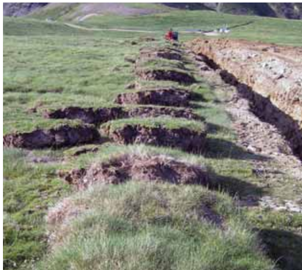
Extracció de pans d'herba a l'hora de realitzar rases. Estació de Cerler Aramón, Osca. www.foliaconsultores.com
