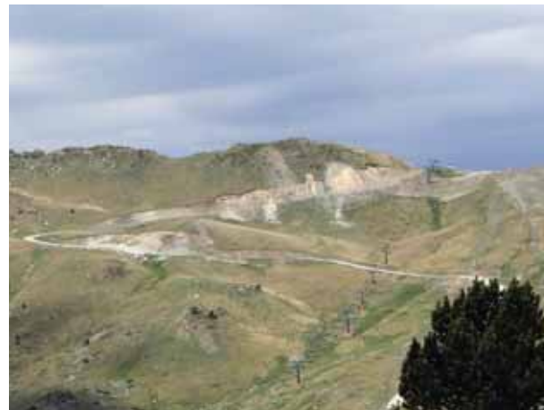
Els desmunts i els terraplens també afecten el prat alpí i les molles per sobre i per sota de l'actuació. Grau Roig, Grandvalira. Juny 2012.
