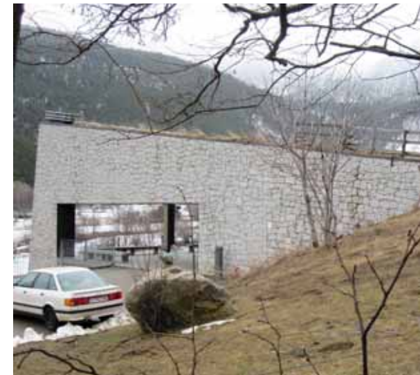
Accés a l'edifici on s'observa la cara sud, oberta al paisatge i al sol i la cara nord, soterrada i a l'abric de les inclemències del temps. MónNatura Pirineus. Autor: Francesc Rius.
