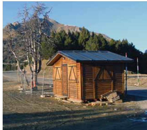
Edificació provisional que acumula brutícia al voltant. Pal, Vallnord.
