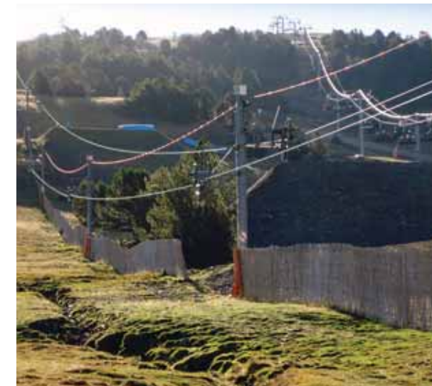
Marcatge dels cables amb petites boies. Soldeu - el Tarter, Grandvalira.
