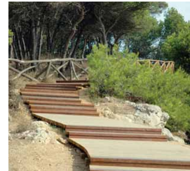
Tanca feta amb troncs provinents d'esbrassar el camí. Camí de Sant Martí d'Empúries, a l'Escalera. L'Alt Empordà, Catalunya.
