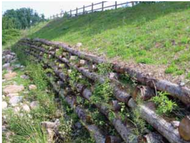
Mur de contenció fet amb entramat viu de troncs que poden provenir de la mateixa intervenció. Autors: Naturalea, www.naturalea.eu
