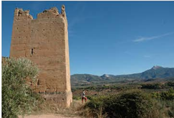
TORRE DEL CARDETE (BENATAE)
