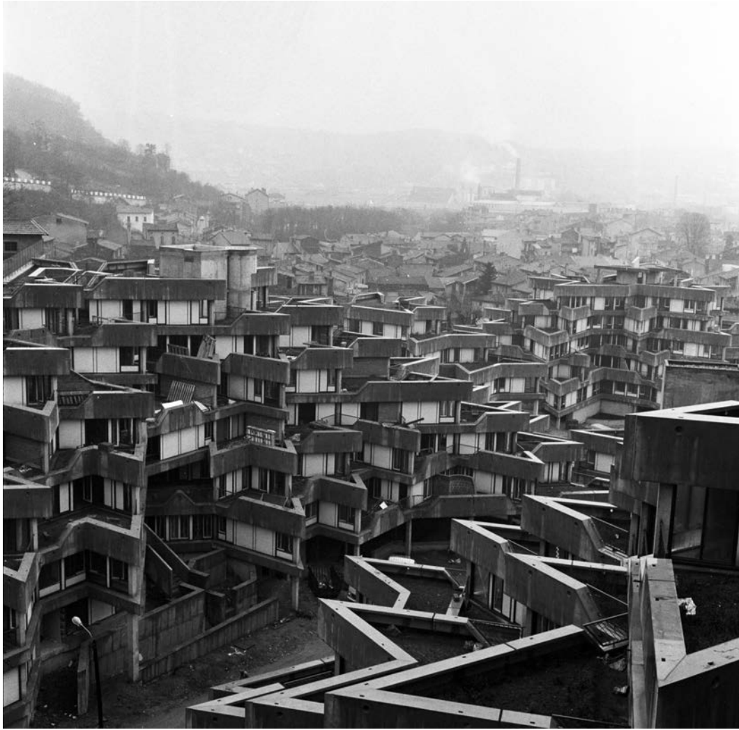
© Bernard Suard MEDDE-MLETR - HLM collectives du plan Construction à Givors - rénovation du vieux Givors (architecte : Jean Renaudie) 1/12/1978
