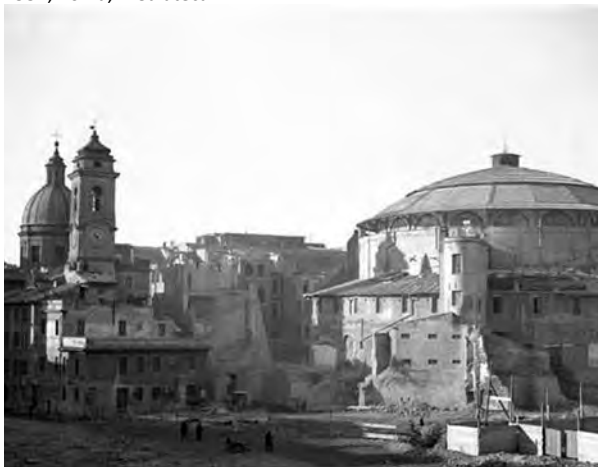
Fig. 37 _ Lavori di demolizioni in corso nell'area dell'Augusteo, 1937; Roma, Mediateca.
