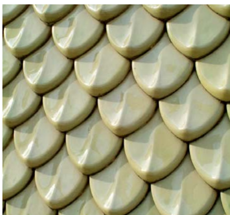
Détail du toit de l'immeuble de la Punxa (Girone, 1918) de Rafael Masó, inspiré des champs de blé situés près de la Ville de Girone
